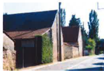
Dans cette rue de Raizeux, les façades pleines dominent
