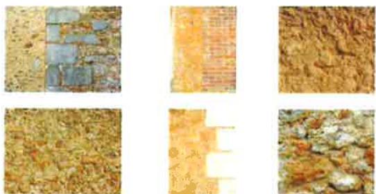
Matériaux rencontrés dans les Yvelines moellons calcaire, meulière, brique, pierre de taille, grès...
