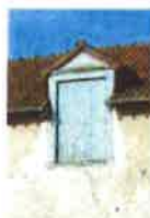
lucarne fenière, deux versants, engagée dans le mur
