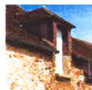
Lucarne à capucine, trois versants, engagée dans le mur.
