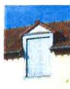
Lucarne fermée, deux versants, engagée dans le mur.
