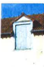
lucarne fermée, deux versants, engagée dans le mur
